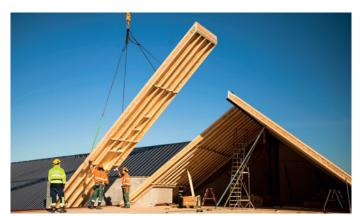
I-BEAM USED IN READY-MADE ELEMENTS
